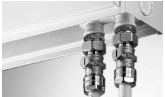
Abb. 36 2-Rohr-Anschluss
